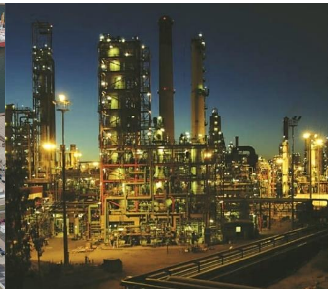
Instalacja Biodiesel dla Porvoo, FINLAND
