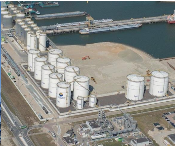
Neste BTT Botlek Tank Terminal
