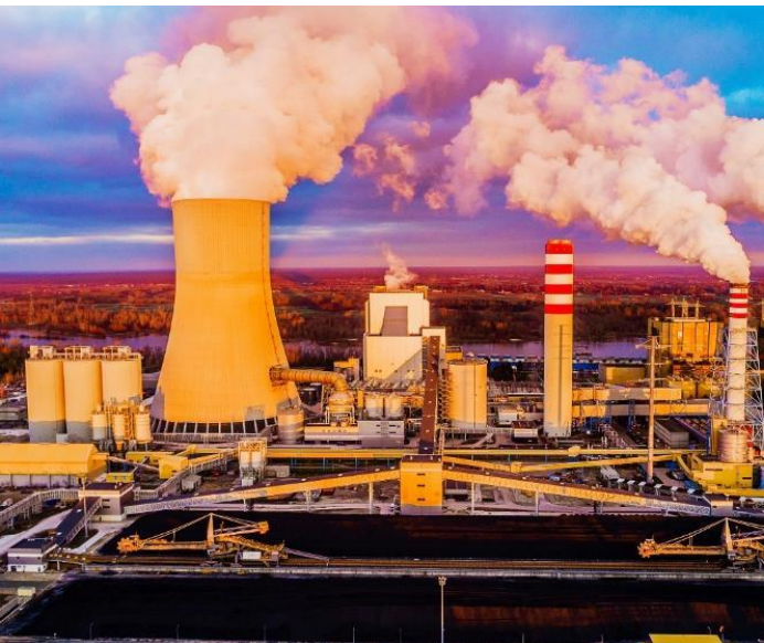
Blok energetyczny B11 w Elektrowni Kozienice
