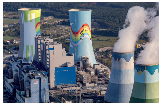
Moc brutto każdego z bloków 900 MWe
