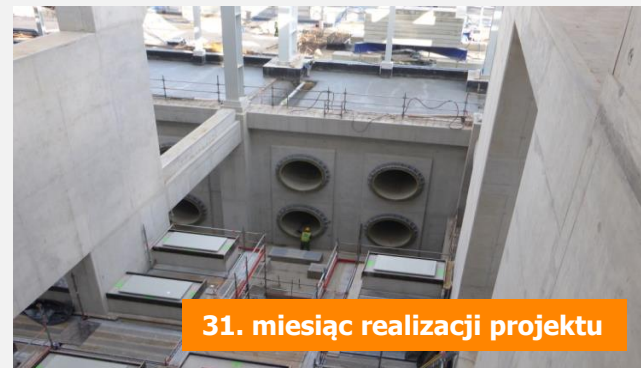
Rurociągi wody chłodzącej w maszynowni.
