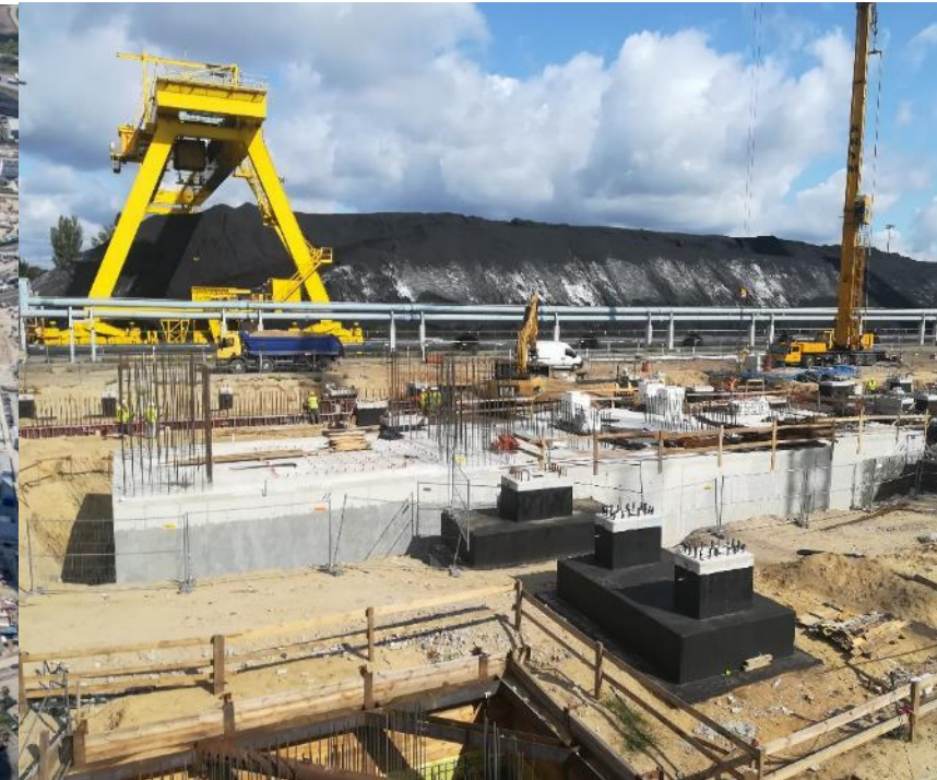
Blok gazowo-parowy w Elektrociepłowni Żerań
