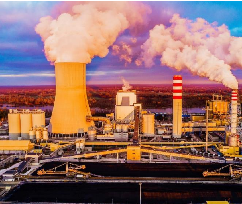
Blok energetyczny B11 w Elektrowni Kozienice
