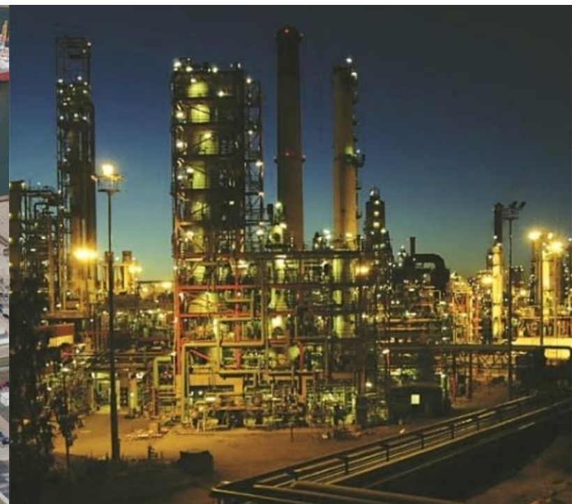
Instalacja Biodiesel dla Porvoo, FINLAND
