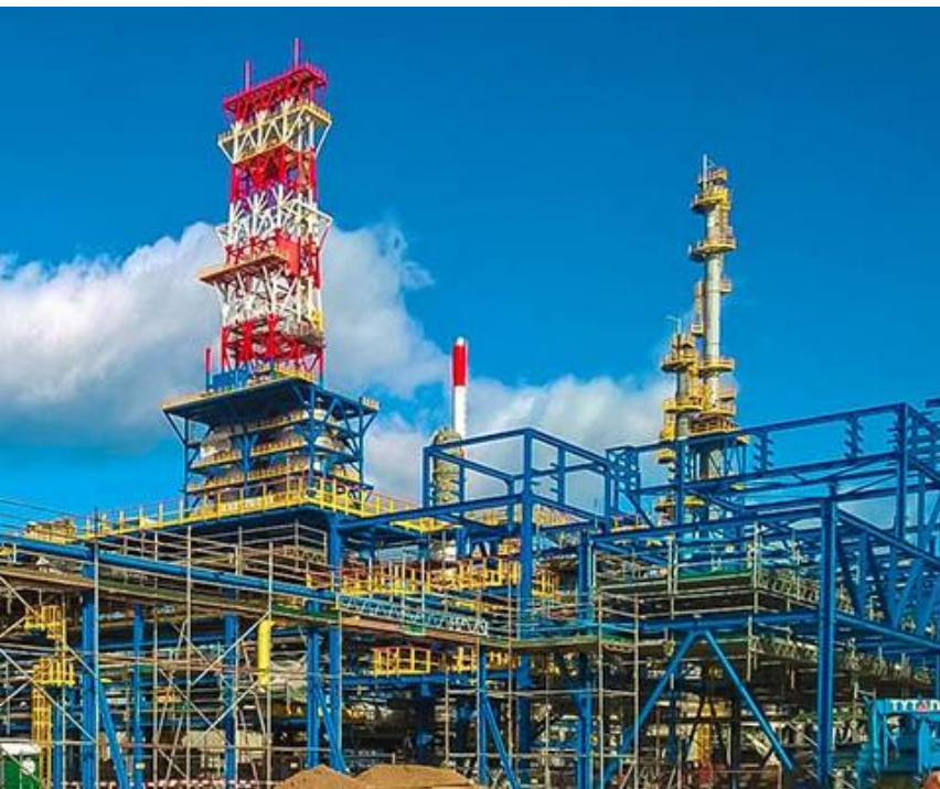
Elektrownie, przemysł petrochemiczny
