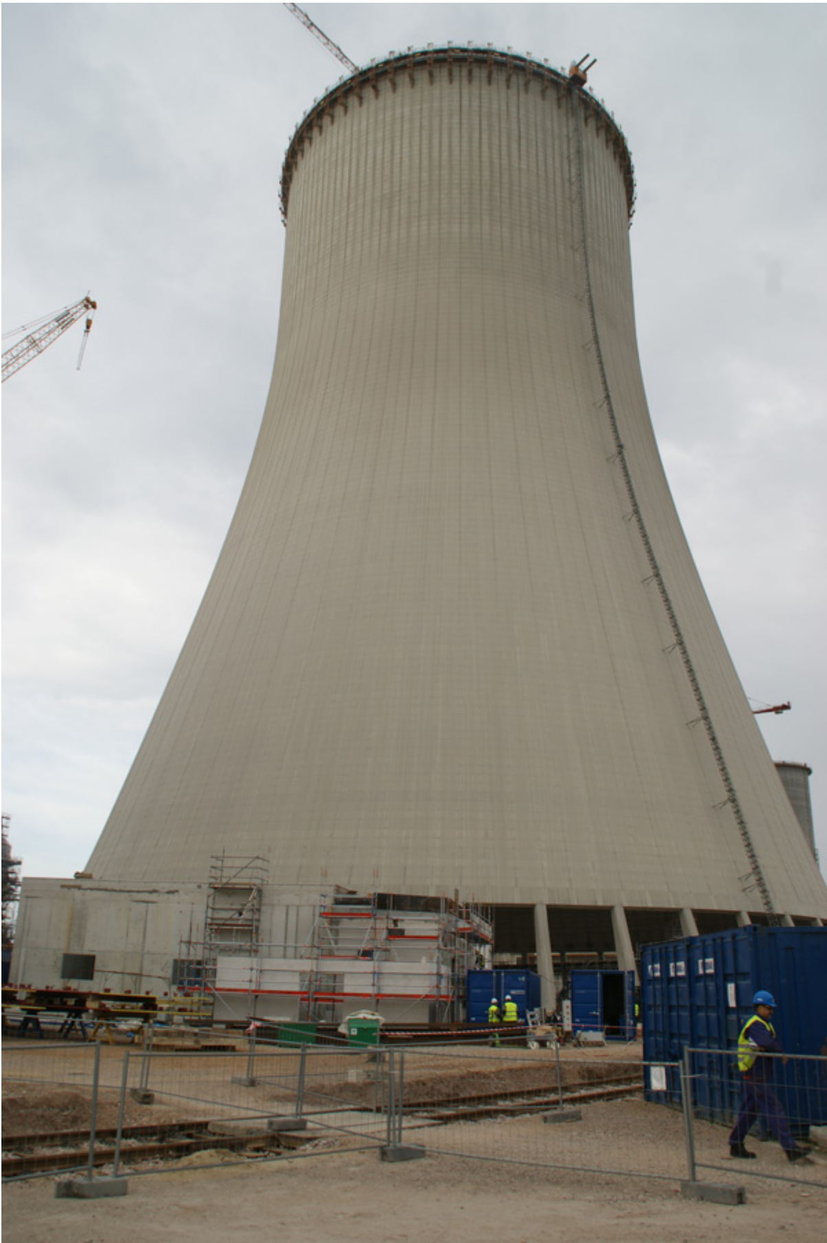
Budowa płaszczu chłodni rozpoczęła się w marcu 2014 roku. Jednym z
